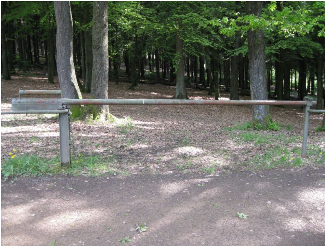
Die neue Schranke mit dem dahinter liegenden "Waldhindernis"
