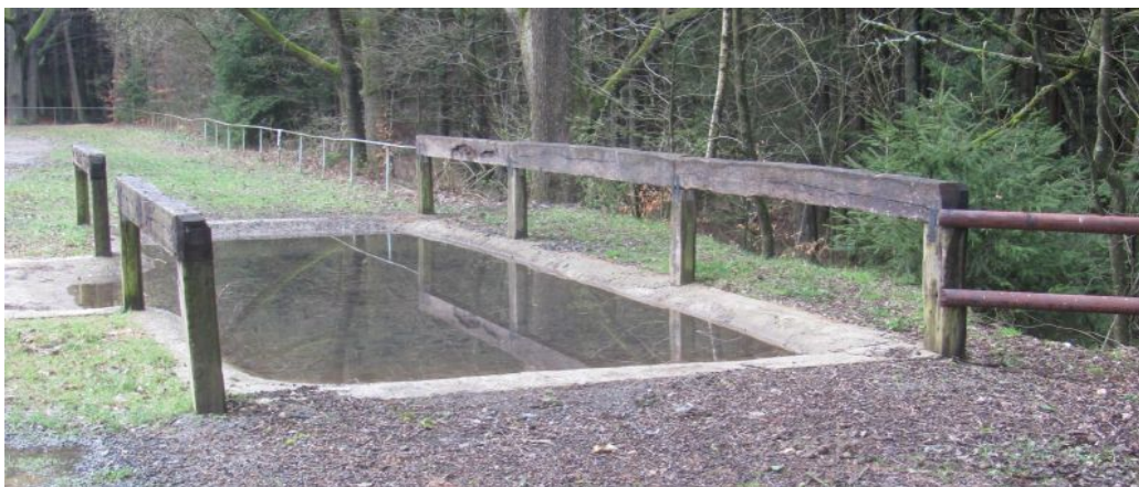
Der neue Wassergraben
