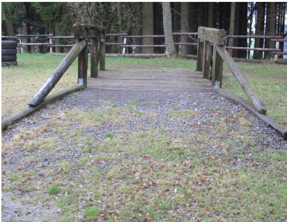
Die Brücke in "Fahrtrichtung"
