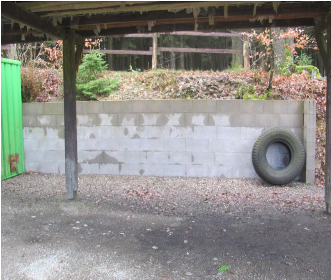
Die Stützmauer zur Böschungssicherung
