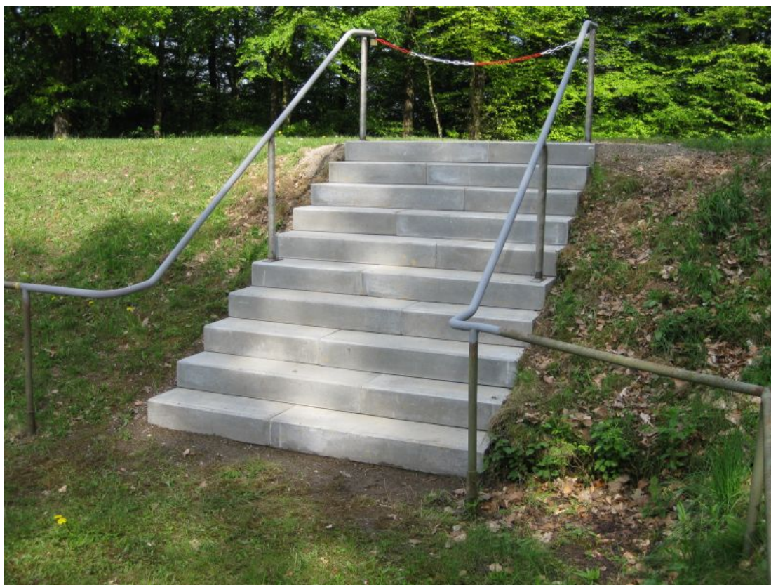
Die neue Treppe in der Süd-Ost-Ecke des Platzes
